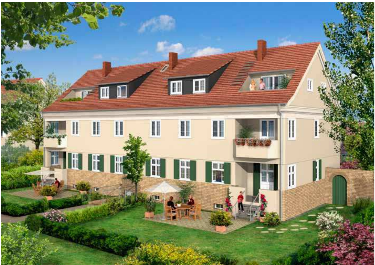
Illustrationen, nach der Sanierung
